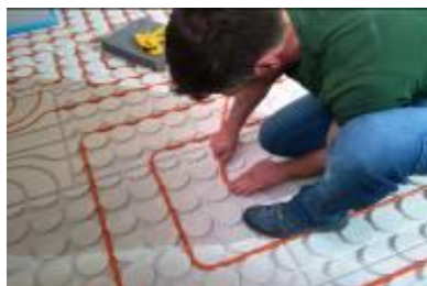
Einlegen des Rohres
