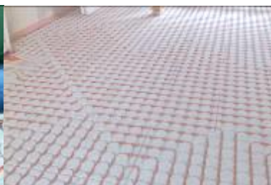
flex-therm-FBH fertig verlegt
