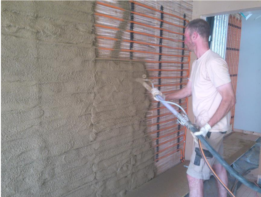
BE-Putzwandheizung beim maschinellen Verputzen mit Lehm in einem Massivholzhaus
